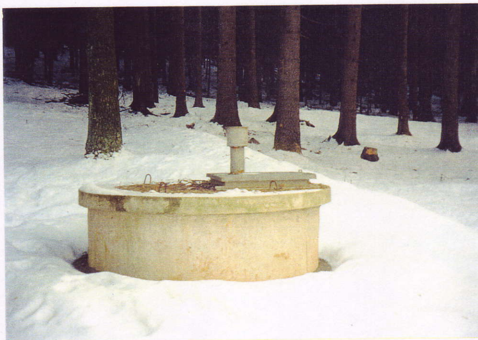
Foto č.5 : Bzová - pramenní jímka( S5) s jímacím zářezem
