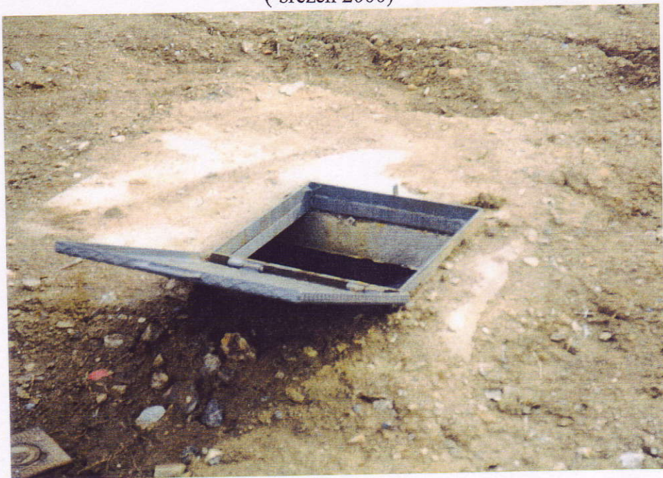
Foto č.12 : Bzová - vodoměrná šachta ( březen 2000)
