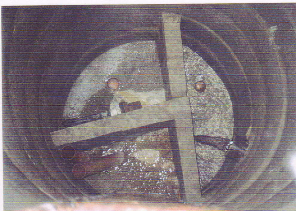
Foto č.6 : Bzová - pramenní jímka (S5) s jímacím zářezem - pohled dovnitř
